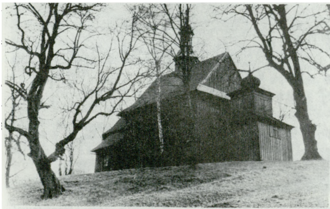
2. Kościół p.w. Św. Sebastiana. Widok od strony północno-zachodniej (fot. T. Chrzanowski)
