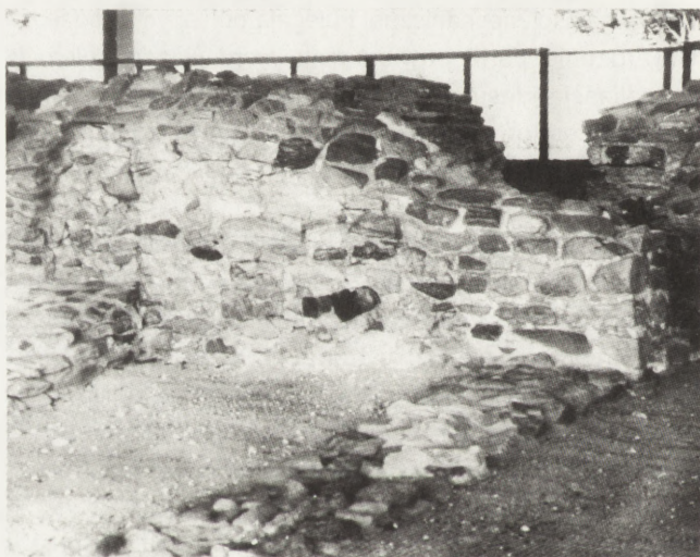
4. Ostrów Lednicki. Zmiany w strukturze zapraw gipsowych w wyniku działania niszczących czynników atmosferycznych. (wszystkie fotografie S. Skibiński)
