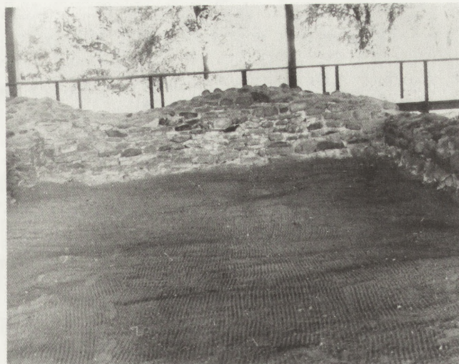
3. Ostrów Lednicki. Zabezpieczenie korony murów zaprawą cementową i widoczne poniżej zmiany w strukturze oryginalnych zapraw gipsowych
