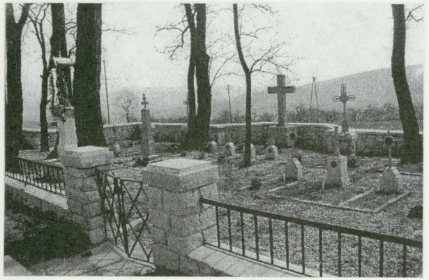
6. Odremontowany cmentarz wojenny Nr 195 Rzuchowa; proj. S.Haller, kwiecień 1988
