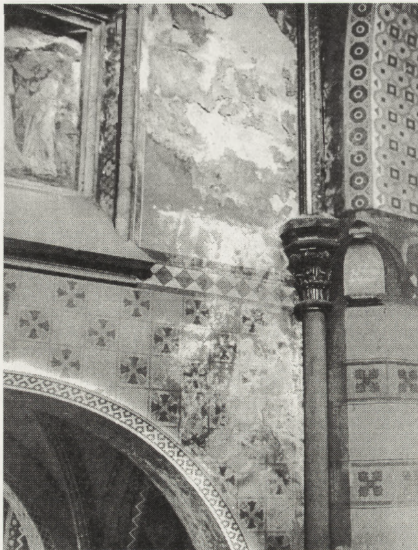
6. Kościół w Złakowie Kościelnym, dekoracja ornamentalna na zębrze — technika klejowa, zlocenia, przełom XIX i XX w. Fot. T. Sawicki
