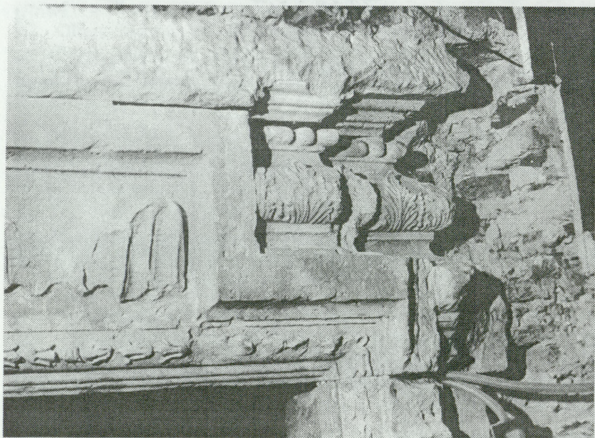
Wieliczka, kościół par. p. w. św. Klemensa. Odkryty podczas prac portal kamienny w wejściu do krypty grobowej pod kaplicą Morstinów, 1693 r. Fragment narożnika. Stan w trakcie prac konserwatorskich (uzupełnianie ubytków). Fot. T. Dziurawiec
