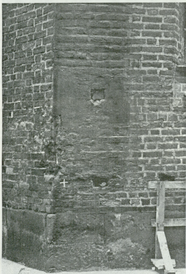
4. Kościół św. Marka w Krakowie. Stan w trakcie usuwania szkodliwych nawarstwień z powierzchni cegiel
