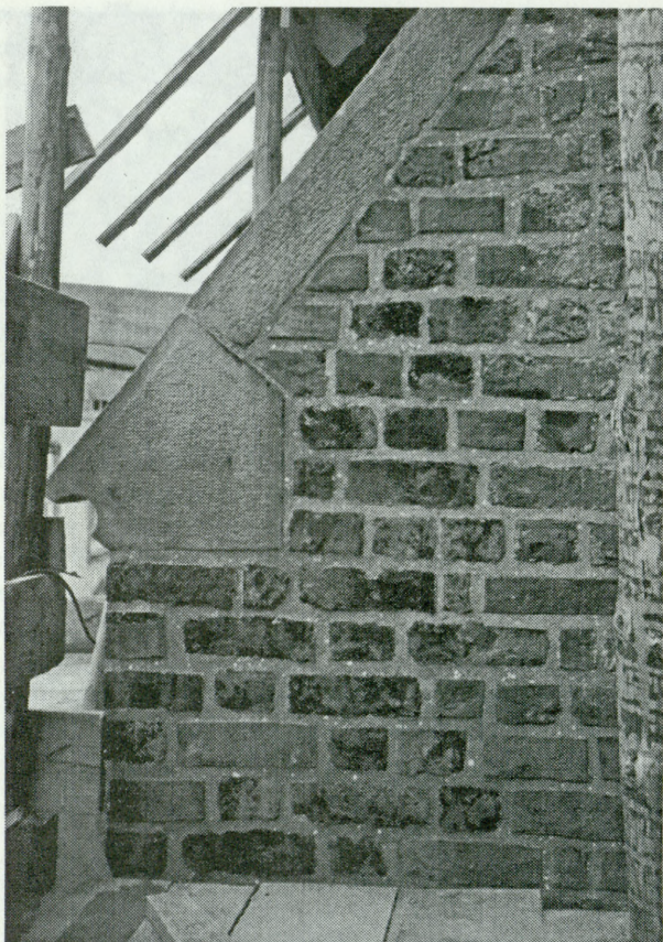
5. Kościół św. Marka w Krakowie. Stan po konserwacji. Sposób fugowania wątków ceglanych — rekonstrukcja formy i składu zaprawy
