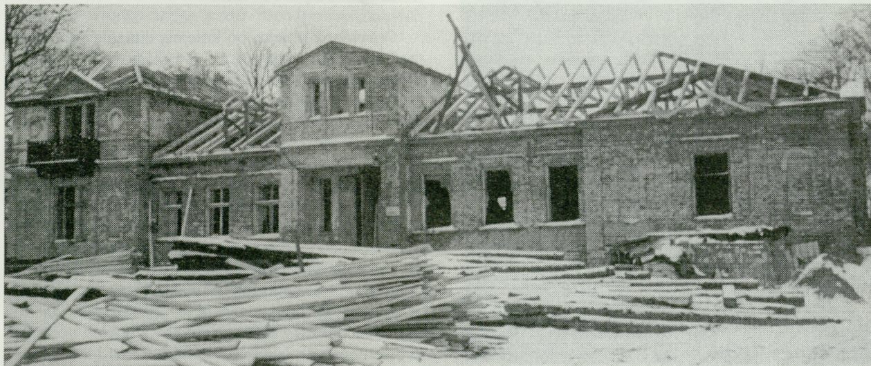
1. Widok ogólny dworu w trakcie remontu w 1994 r. Wszystkie fot. J. Strzelecki
