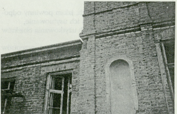
5. Ściąg stalowe w ścianach podłużnych nad parterem 5. Steel braces on oblong walls over the ground floor
