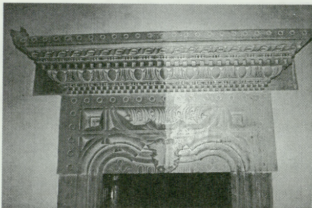
7. Portal na parterze Schodów Poselskich, ściana pd. (zaprojektowany przez A. Szyszko-Bobusza w miejscu, gdzie pierwotnie nie było portalu) w trakcie oczyszczania — widoczny stopień zabrudzenia
