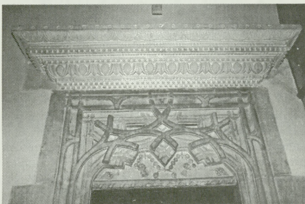
10. Portal w sieni Zbrojowni na parterze skrzydła wsch., ściana pd., stan po konserwacji — pozostawione ślady przepalenia i różnica kolorystyczna elementów autentycznych i wymienionych (gzyms)
