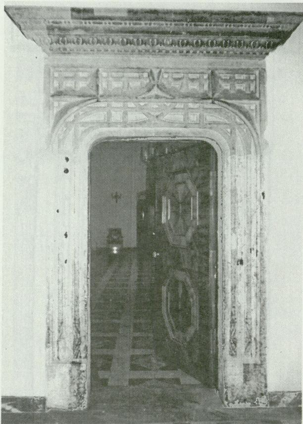
4. Portal w sali I p. skrzydła pn., przyschodach Senatorskich, późnogotycka dekoracja węgarów i nadproża, gzyms renesansowy, stan po konserwacji. Fot. P. Stępień
