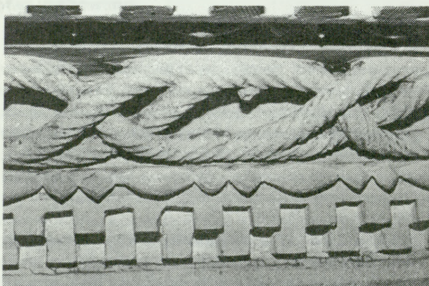
8. Fragment dekoracji gzymsu portalu w tzw. Szarej Sieni na I p. skrzydła usch. po oczyszczeniu — widoczne nikielne ślady warstw malarskich
