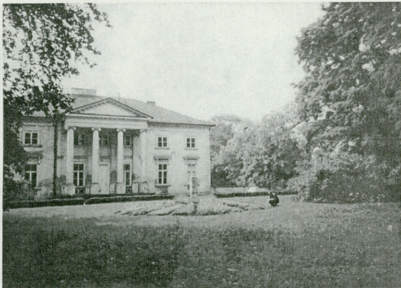
Igołomia, park pałacowy, wnętrze przed główną elewacją pałacu na górnym tarasie i klomb z kolumną; stan z 1995 r. Fot. M. Majka.
