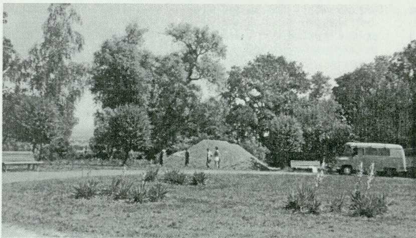
Mogilany, park dworski, prace przy odtwarzaniu kopca widokowego w północnej, krajo- brazowej części parku; stan 1994 r. Fot. B. Górski
