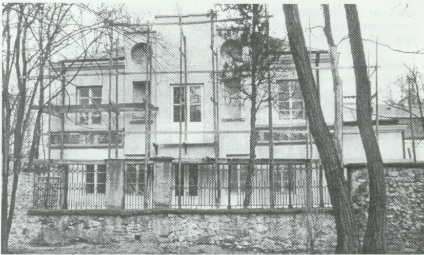
Kielce, oficyna pałacyku T. Zielińskiego, ul. Zamkowa 5, elewacja pd. — podczas remontu. Fot. W. Siudowski 1994 r.
