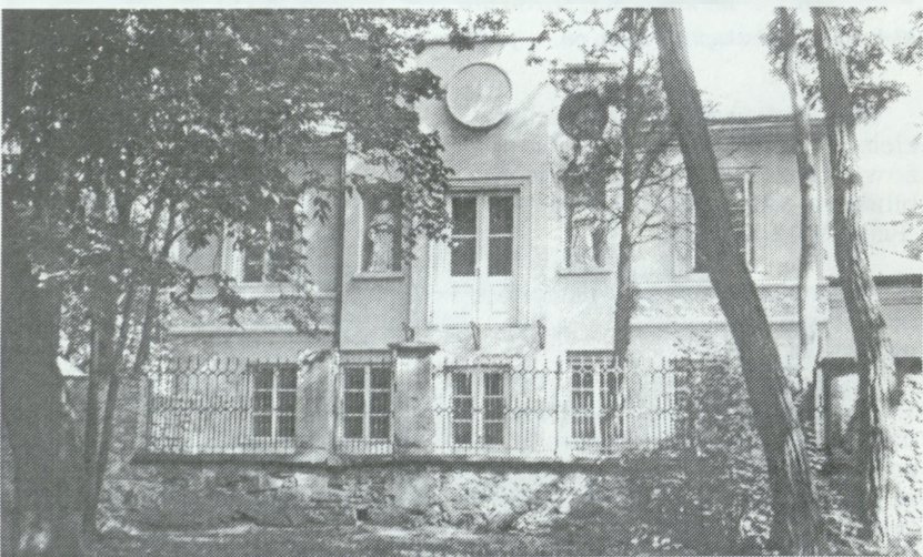
Kielce, oficyna pałacyku T. Zielińskiego, ul. Zamkowa 5, elewacja pd. — po remoncie. Fot. W. Siudowski 1993 r.
