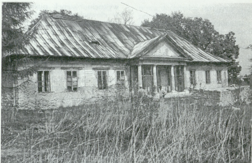
Nadzów, dwór — fasada podczas remontu. Fot. O. Chojnacki 1992 r.
