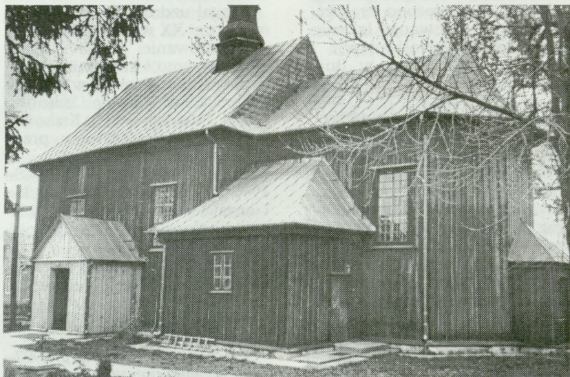
Cudzynowice, kościół parafialny, elewacja pd. — po remoncie. Fot. O. Chojnacki 1993 r.
