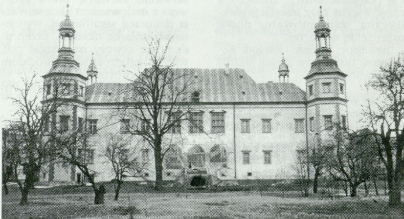
Kielce, pałac pobiskupi — korpus główny podczas konserwacji wystroju loggii i remontu elewacji zach. Fot. W. Siudowski 1993 r.
