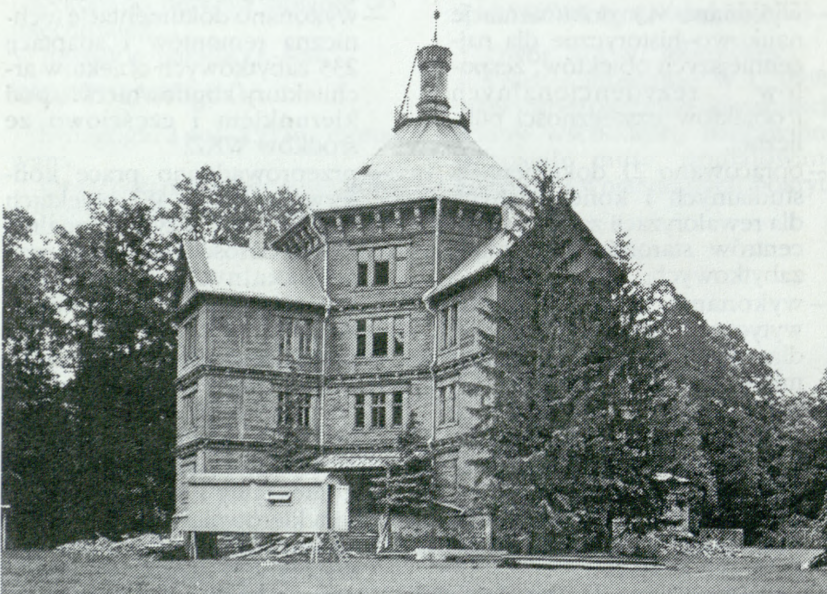
Antonin, pałac myśliwski Radziwiłłów w trakcie prac konserwatorskich. Fot. Archiwum WKZ
