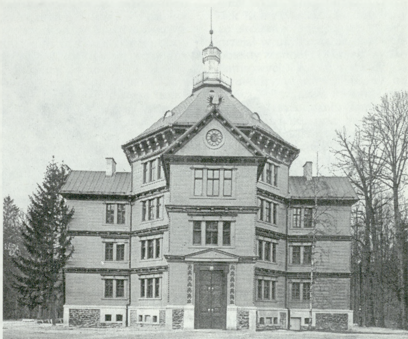
Antonin, pałac myśliwski Radziwiłłów po pracach konserwatorskich. Fot. Archiwum WKZ
