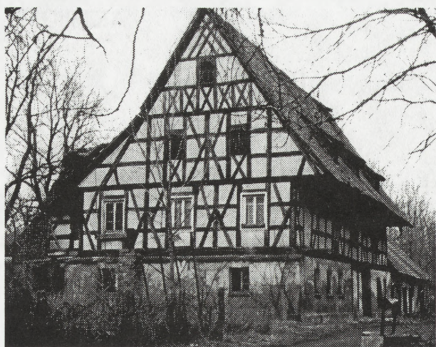
1. Dwór w Oporowie, stan obecny. Fot. A. Górski
