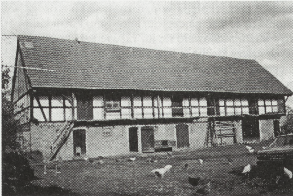
3. Bruskowo Male, przykład budynku gospodarczego z galerią o murowanym przyziemiu i piętrze w konstrukcji szkieletowej, 2 poł. XIX w. Fot. S. Szpilewski
