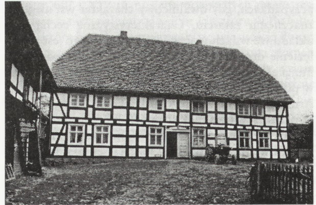
4. Swolowo nr 23, przykład szerokofrontowego, piętrowego domu mieszkalnego, w konstrukcji szkieletowej, z dachem naczółkowym k. XVIII/XIX w. Fot. E. Wójtowicz
