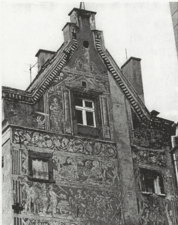
3. Szczytowa część kamienicy, stan przed konserwacją, 1992 r.
