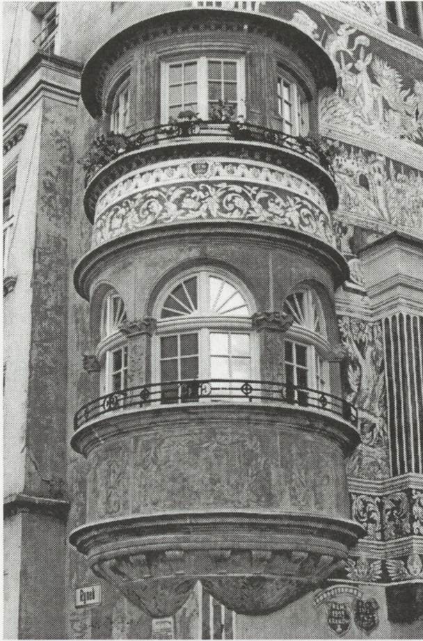
9. Wykusz po ponownym złożeniu (z zachowaniem formuły anastylozy) i zakończeniu konserwacji, 1994 r.
