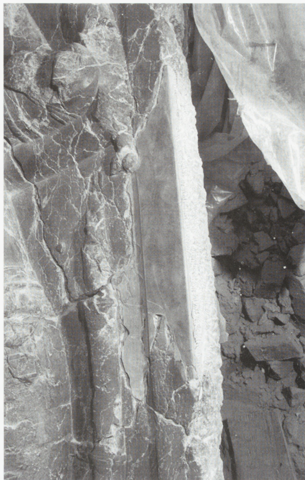
19. Płyta J. Dobka Łowczowskiego — zrekonstruowany w analogicznym materiale fragment bloku, po wklejeniu i wstępnej obróbce rzeźbiarskiej. Stan z 1994 r. Fot. W. Procyk
