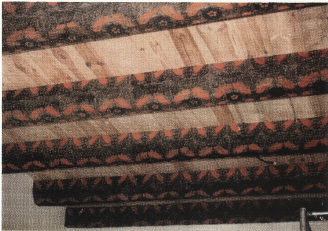
10. Papierowa koltryna z belek stropowych z sali na drugim piętrze budynku Collegium Juridicum w Krakowie, po zrekonstruowaniu na stropie, własność Uniwersytetu Jagiellońskiego. Stan po konserwacji. Fot. J. Charytoniuk
