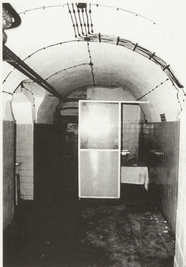
9. Kształt piwnicy pod pałacem pochodzącej z rozbudowy Czartoryskich (pom. 018). Fot. autorów
