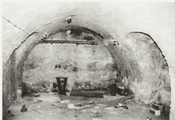
7. Jedna z piwnic (pom. 021) dworu bpa Potockiego zachowana w niezmiennym kształcie pod obecnym pałacem. Ściany pokryte są miętko kładzioną wapienną wyprawą a podłoga wykończona cegłą. Sugeruje się pozostawienie wyrazu wnętrza bez zmian. Fot. autorów
