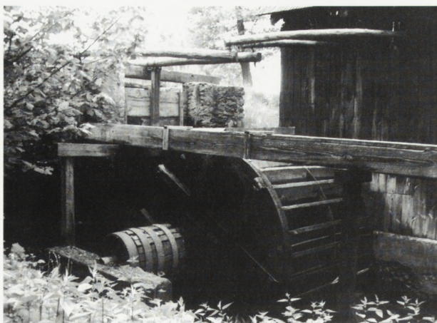
1. Stara Kuźnica, gm. Końskie, duże koło wodne napędzające młot kuzienny. Wszystkie fot. A. Zbiegieni
