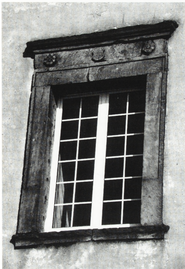
22. Barokowe obramienie okienne ze śladami po mocowaniu krat z wstawionym plastikowym oknem szklonym jedną taflą szklaną z pozornymi szczeblinami (Święty Krzyż, zabudowania klasztorne). Fot. J. Lewicki 1997
