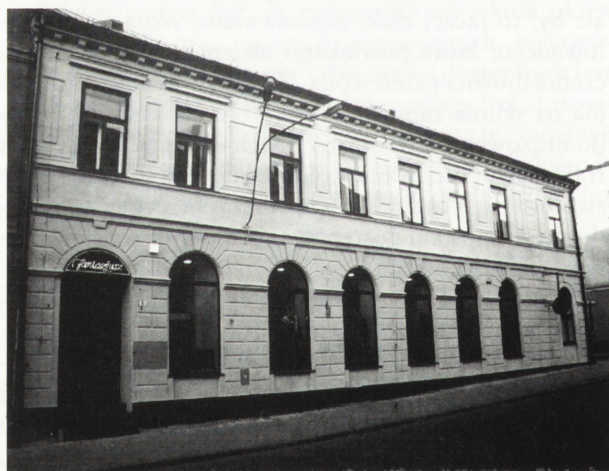
21. Klasycystyczna fasada z usuniętą na części elewacji zabytkową stolarką, która stanowiła świadomie zaprojektowaną nierozdzieloną jej część (Kielce, ul. Sienkiewicza 8, 1 poł. XIX w.). Fot. J. Lewicki 1998
