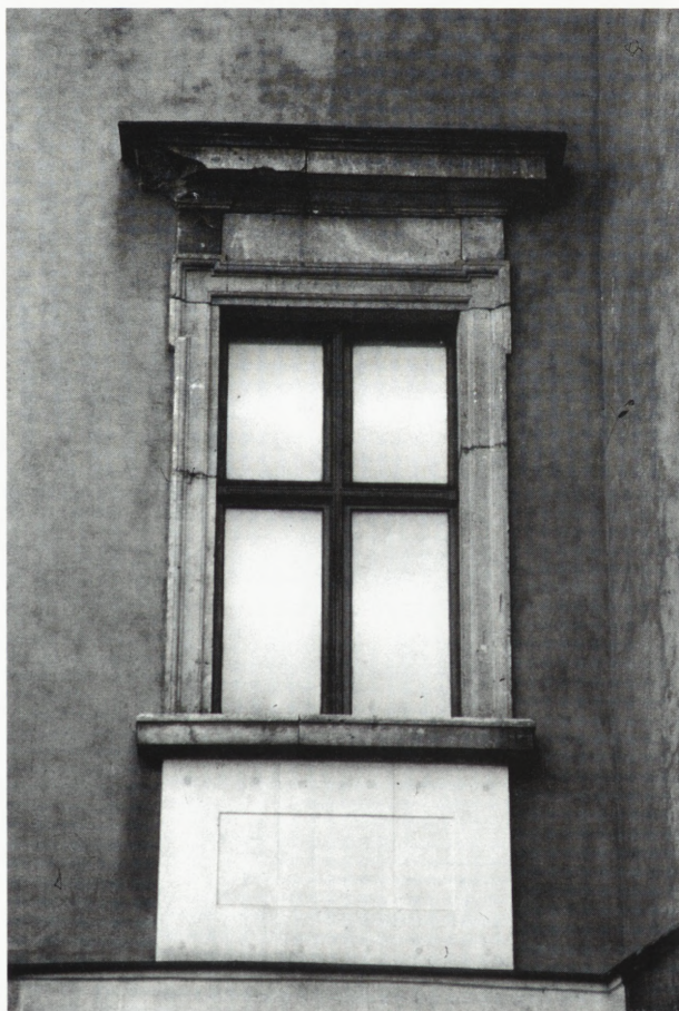
19. Rekonstruowane barokowe obramienie okienne ze współcześnie projektowaną stolarką o podziale nawiązującym do barokowego (umieszczenie ślimienia), oszklenie współczesne (brak rekonstrukcji oszklenia) (Warszawa, Zamek Ujazdowski). Fot. J. Lewicki 1998
