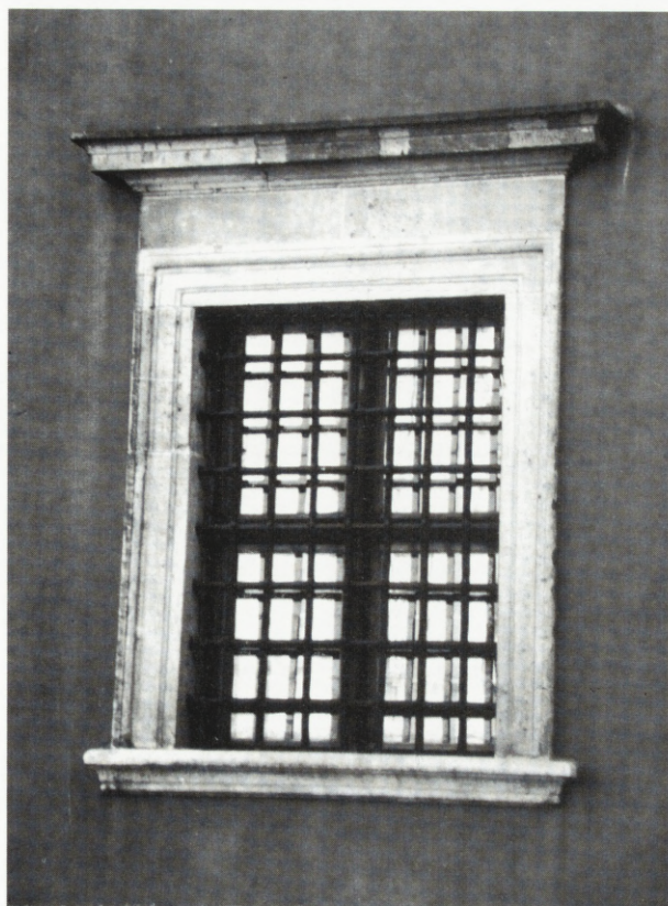
17. Rekonstruowane barokowe obramienie okienne ze współcześnie projektowaną stolarką o podziale, oszkleniu i z kratą wzorowaną na rozwiązaniach barokowych. Oszklenie i konstrukcja nawiązujące do barokowego z elementami współczesnymi (Warszawa, Zamek Królewski). Fot. J. Lewicki 1998
