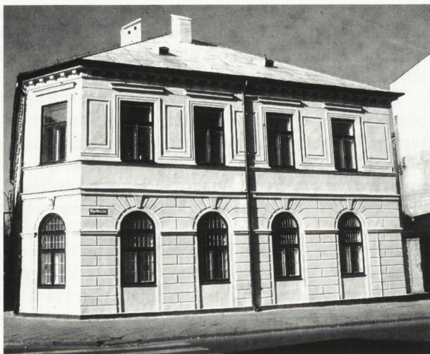
20. Klasycystyczna fasada z zabytkową stolarką, która stanowi świadomie zaprojektowaną nierozdzieloną jej część (Kielce, ul. Sienkiewicza 8, 1 poł. XIX w.). Fot. J. Lewicki 1997
