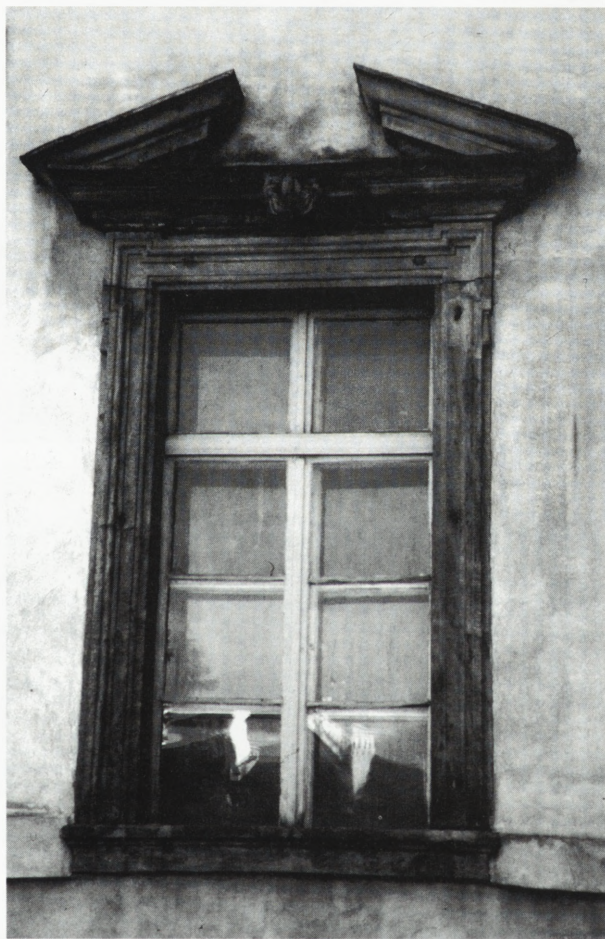
14. Zabytkowa klasycystyczna stolarka okienna w profilowanym barokowym obramieniu ze śladami mocowania krat (Kielce, Pałac Biskupi, fasada, obramienie przed 1644 r., stolarka 1868 r.). Fot. J. Lewicki 1997
