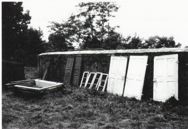
1. Usunięta zabytkowa stolarka (Oporów, zespół zamkowy, stolarki klasycystyczne). Fot. J. Lewicki 1997
