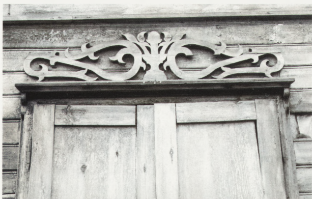
9. Tak precyzyjne wykonanie nadokiennika wymagało od stolarza dużej biegłości i dobrych narzędzi (ul. Sikorskiego 18)
