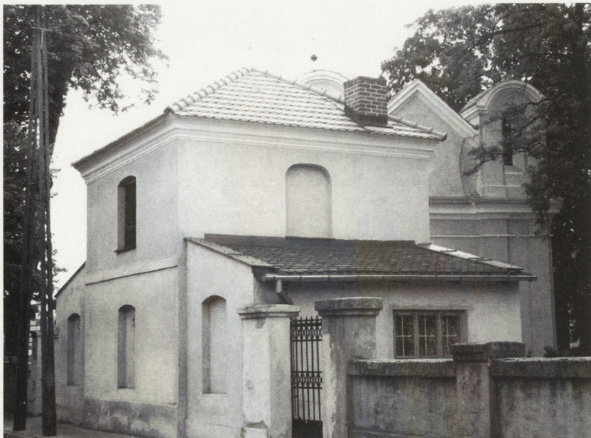
Skierniewice — dawny szpital po remoncie. Fot. M. Jędrzejewski, 1998 r.
