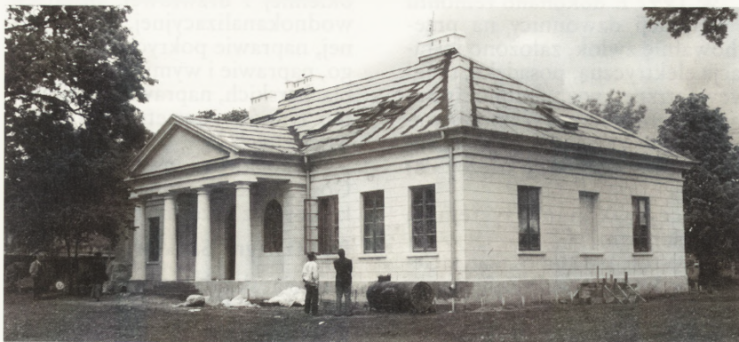
Kąty — dwór w trakcie remontu. Fot. M. Jędrzejewski, 1997 r.
