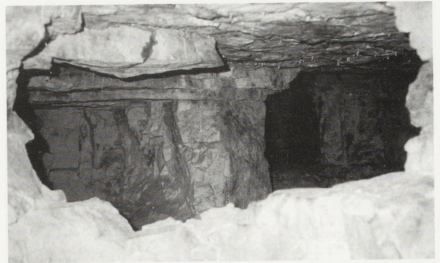
4. Metoda scalania górotworu za pomocą żywic okazała się niestety pomyłką
