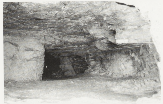
5. Niedobra metoda zabezpieczeń może czasami przynieść więcej szkody niż pożytku
