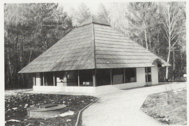
6. Pawilon trasy turystycznej nr 1 otoczony opaską odwadniającą
