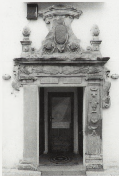
10. Grodno, kościół pobrygidkowski, obecnie ss. nazaretanek, portal boczny, 1634–1642, po pracach zabezpieczających. Fot. J. Smaza, 1996 r.
