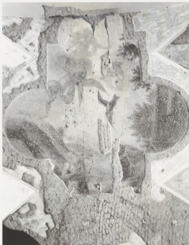
5. Konarzewo, pałac. Plafon w jadalni z przedstawieniem sceny Karminie Świętych Pustelników — stan po odsłonięciu spod wtórnych tynków i przemalowań. Fot. J. Miecznikowski
