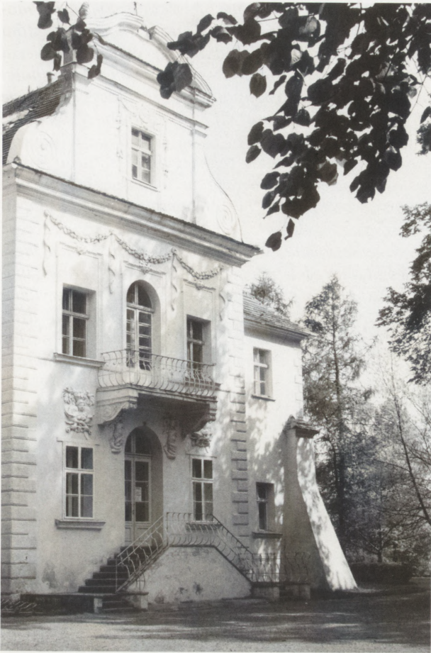
3. Konarzewo — ryzalit elewacji ogrodowej. Fot. T. Talarczyk
