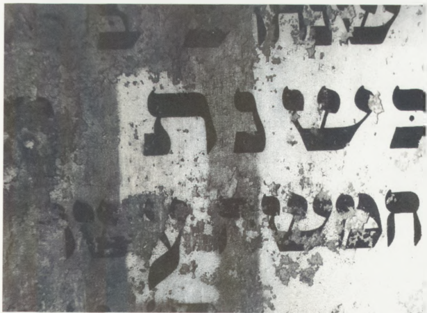
4. Oczyszczanie malatury z brudu. Z lewej strony stan przed oczyszczeniem
