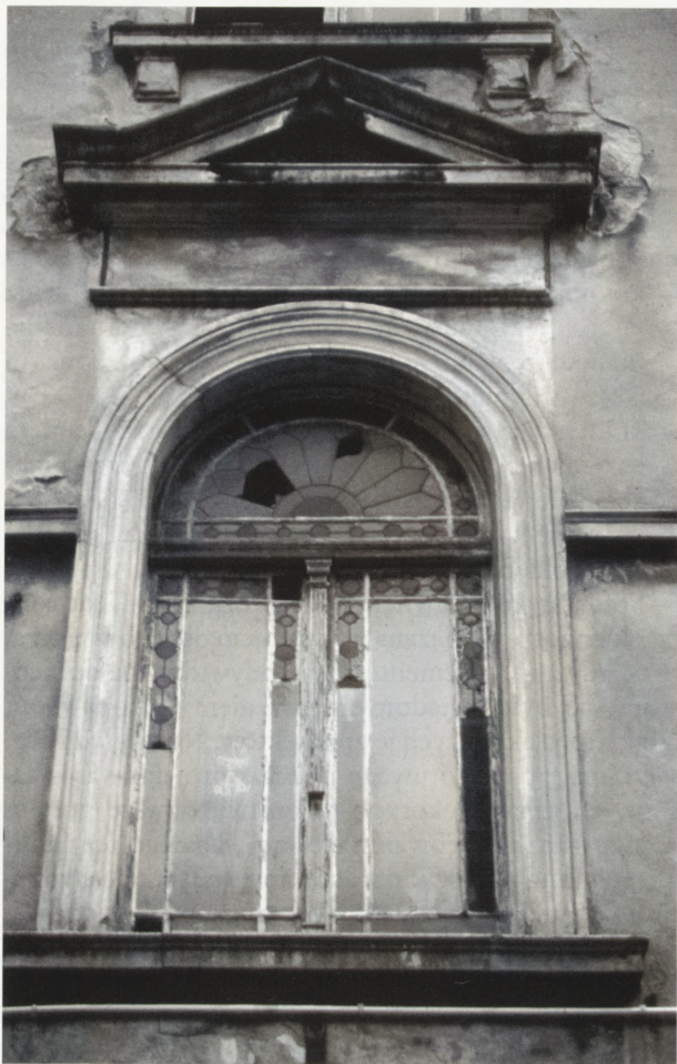
1. Ochronie i konserwacji winno podlegać całe okno wraz z opracowaniem kolorystycznym. Składa się na nie obramowanie okna, stolarka i oszklenie (Toruń, kamienica czynszowa, ul. Klonowica 24, pocz. XX w.). Fot. J. Lewicki, 2000 r.
