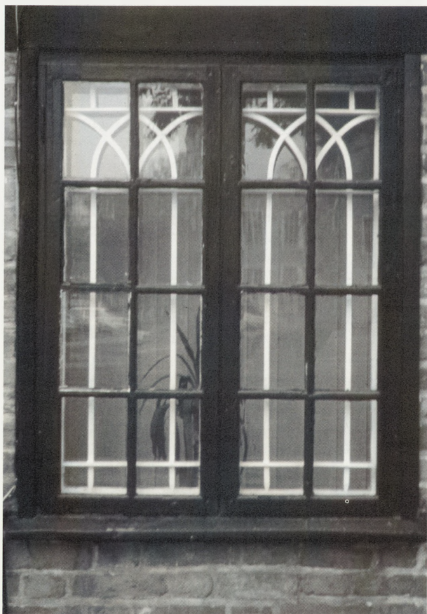
9. Okna z kolorystyką nawiązującą do historycznych rozwiązań. Widoczne różnicowanie kolorystyczne opracowania zewnętrznych skrzydeł okiennych i wewnętrznych (kolor biały). (Gdańsk, Głównie Miasto, Kaplica Królewska). Fot. J. Lewicki, 1999 r.
