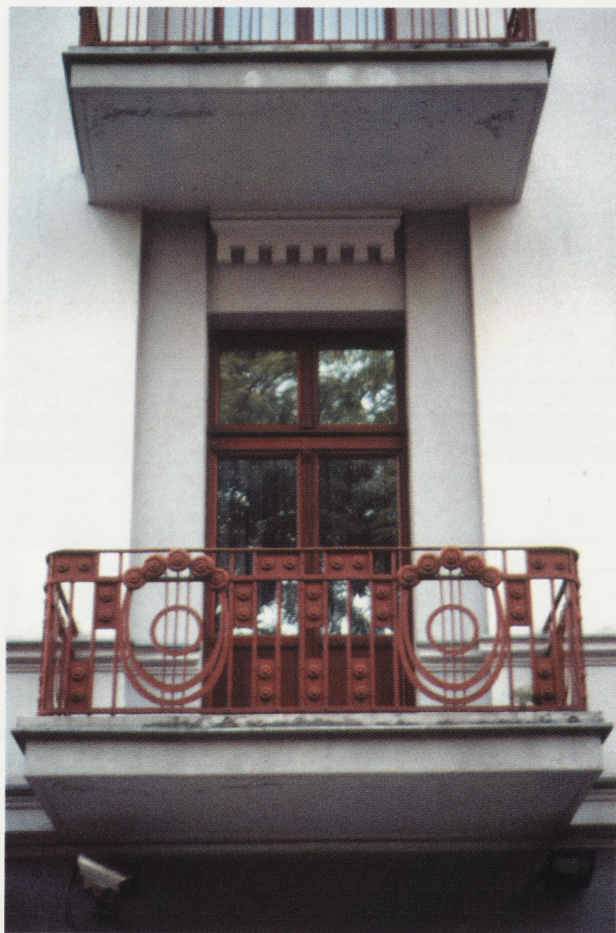
7. Okno balkonowe i balustrada balkonu o formach modernistycznych nawiązujących do secesji. Mimo niezbyt dokładnego odtworzenia pierwotnej barwy osiągnięto przywrócenie nastroju całej elewacji. (Lublin, kamienica z pocz. XX w.). Fot. J. Lewicki, 1999 r.
