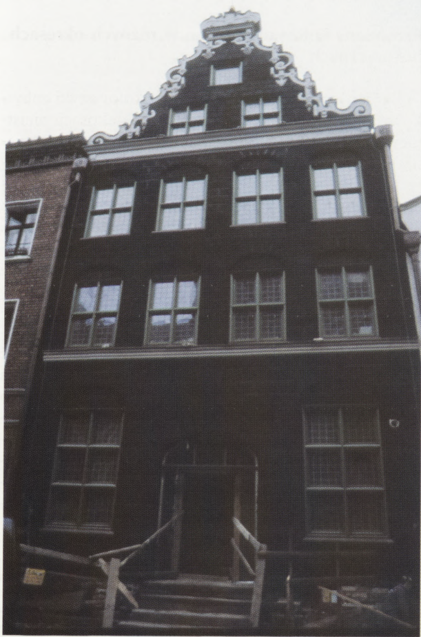
6. Przykład udanej kompozycji konserwatorskiej w duchu historycznym. Odtworzone opracowanie kolorystyczne barokowej elewacji nawiązujące do historycznego z odtworzoną kolorystyką stolarki w duchu baroku (kolor zielony). Podział i oszklenie na wzór barokowy (Toruń, Nowe Miasto, ul. Male Garbary 7). Fot. J. Lewicki, 2000 r.
