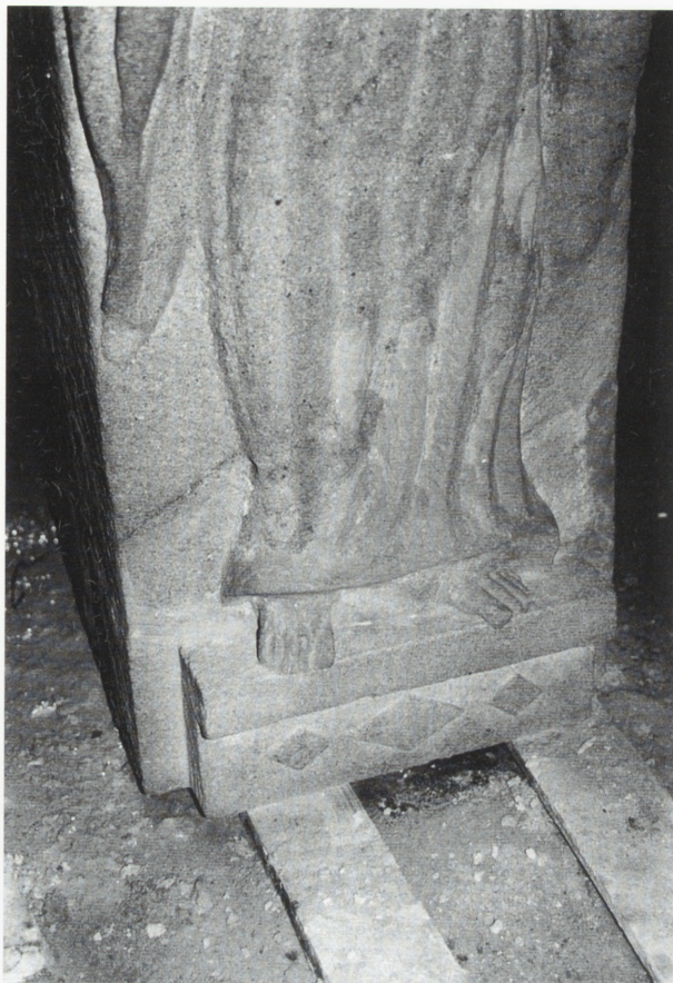
10. Kapliczka Bożej Męki w Tychach z 1820 r. Fragment elementu piaskowcowego po konserwacji. Z uwagi na słabą zwięzłość piaskowca, odznaczającego się małą ilością spoiwa, zastosowano do jego rekonstrukcji średnioziarnistą masę mineralną o niskiej wytrzymałości. Fot. A. Niemczyk-Janik
