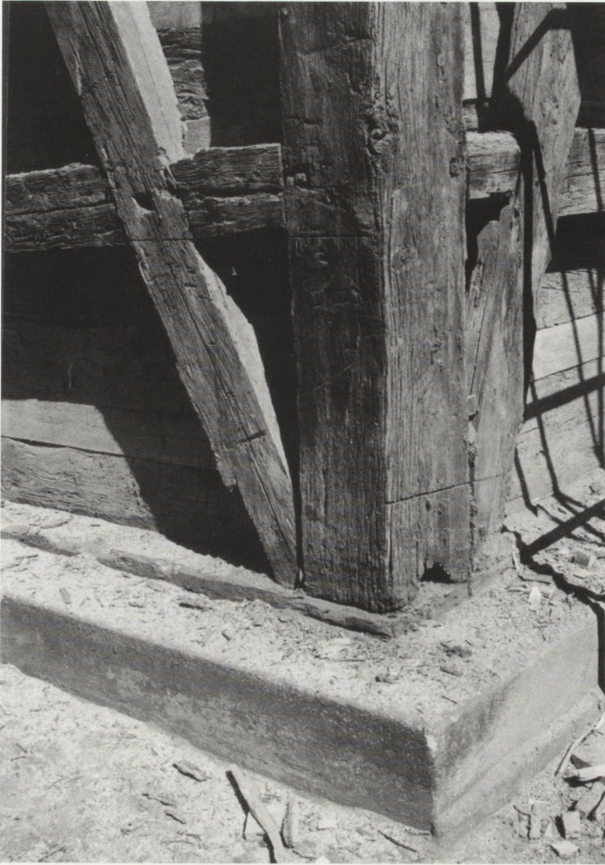
7. Słup narożny (południowo-zachodni) konstrukcji szkieletowej nawy, stan z maja 1999 r.
