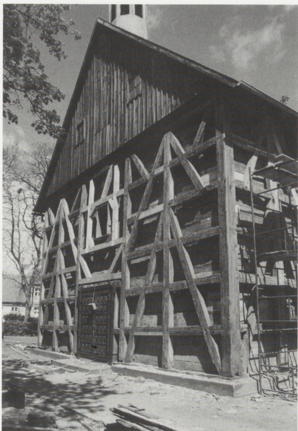
5. Konstrukcja zachodniej ściany nawy, stan z maja 1999 r.
