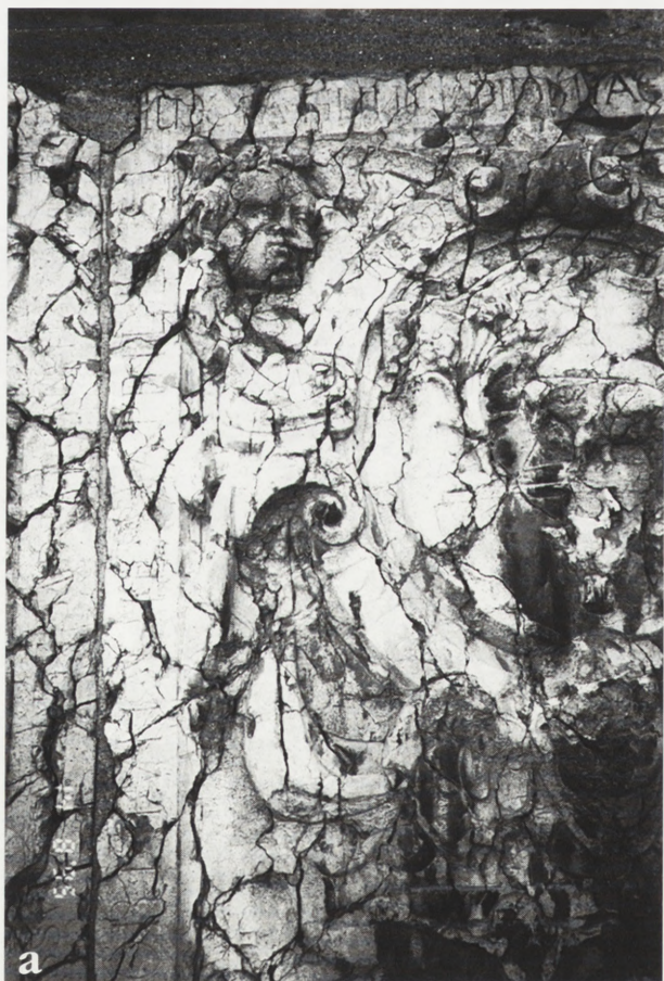
10. Proces wylugowania struktur sekrecyjnych fazy miękkiej: a — na powierzchni jednego z renesansowych epitafiów z czerwonego marmuru umontowanych w ścianę Kaplicy św. Michała w Koszycach, fot. W. Procyk; b — (SEM) obraz tych form po wylugowaniu minerałów ilasto-żelazistych, próba 3/III, powiększenie 180 x, przekrój. Fot. R. Kopczyński
