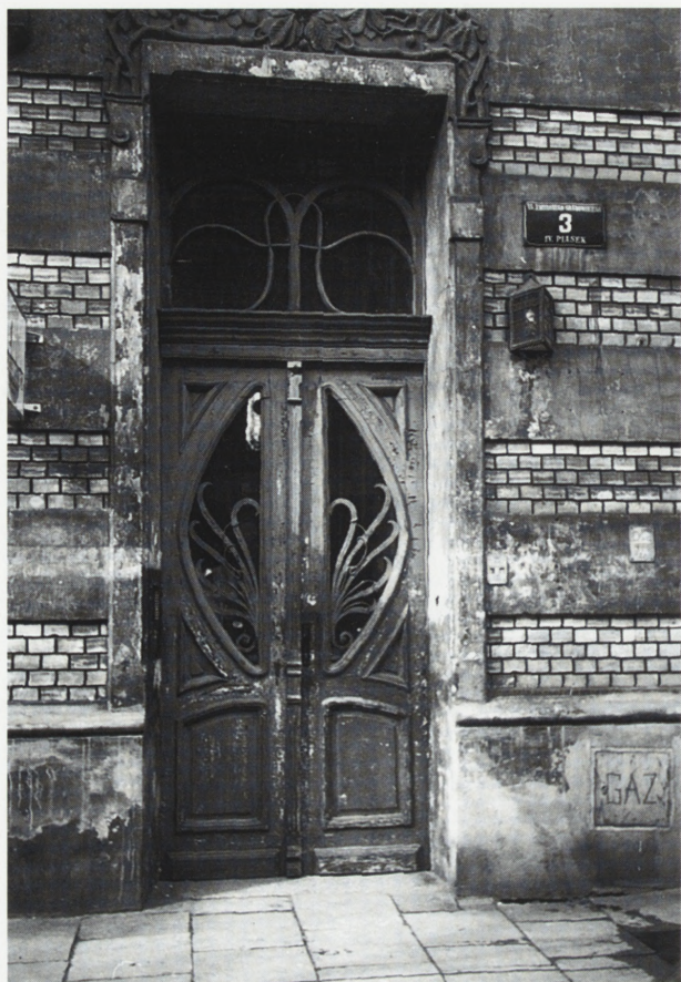
1. Kraków, ul. Grabowskiego 3, drzwi w kamienicy proj. arch. Beniamina Torbego, 1906 r. Wszystkie fot. A. Janicka, 2000
