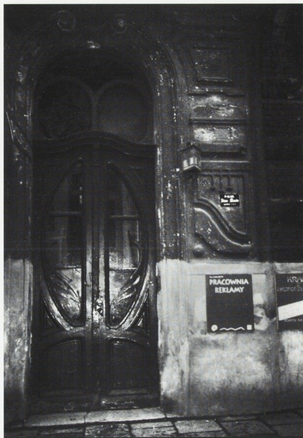
2. Kraków, ul. Piłsudskiego 9, drzwi w kamienicy proj. arch. Beniamina Torbego, 1906
