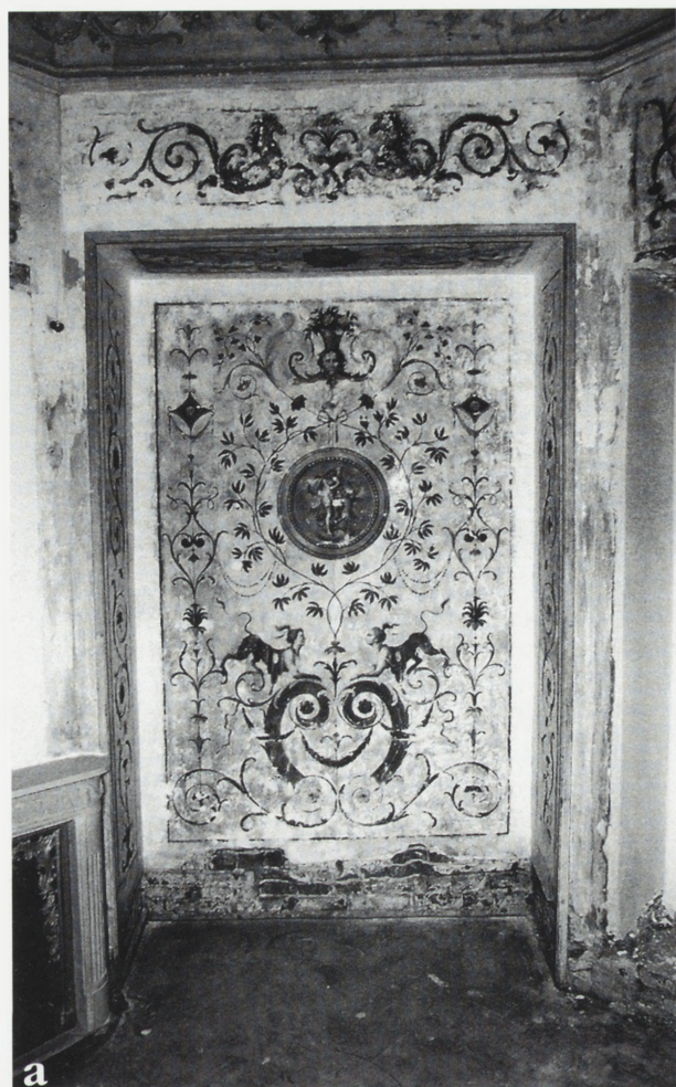
8. Kompozycja grotteskowo-arabeskowa we wnęce ściany wschodniej: a — w trakcie konserwacji, po oczyszczeniu i założeniu kitów; b — dół wnęki w trakcie podmalowania tła; c — góra wnęki po konserwacji. Fot. R. Stasiuk (a), R. Gazda (b, c)
