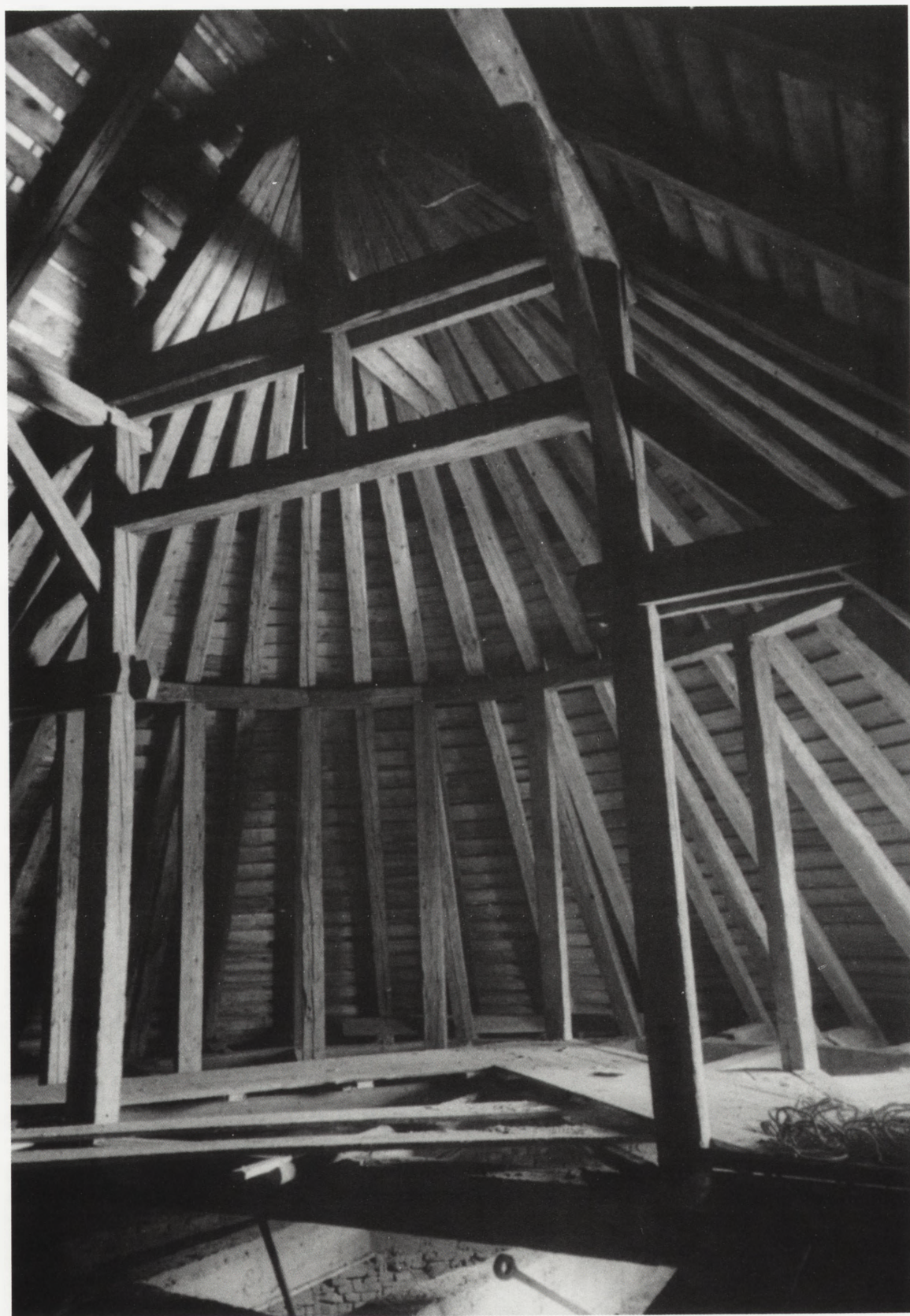
9. Brzozów, kościół parafialny 1676–1686 — zakończenie więźby dachowej nad półkolistym zamknięciem prezbiterium. Fot. J. Langda 1971; zbiory IS PAN
