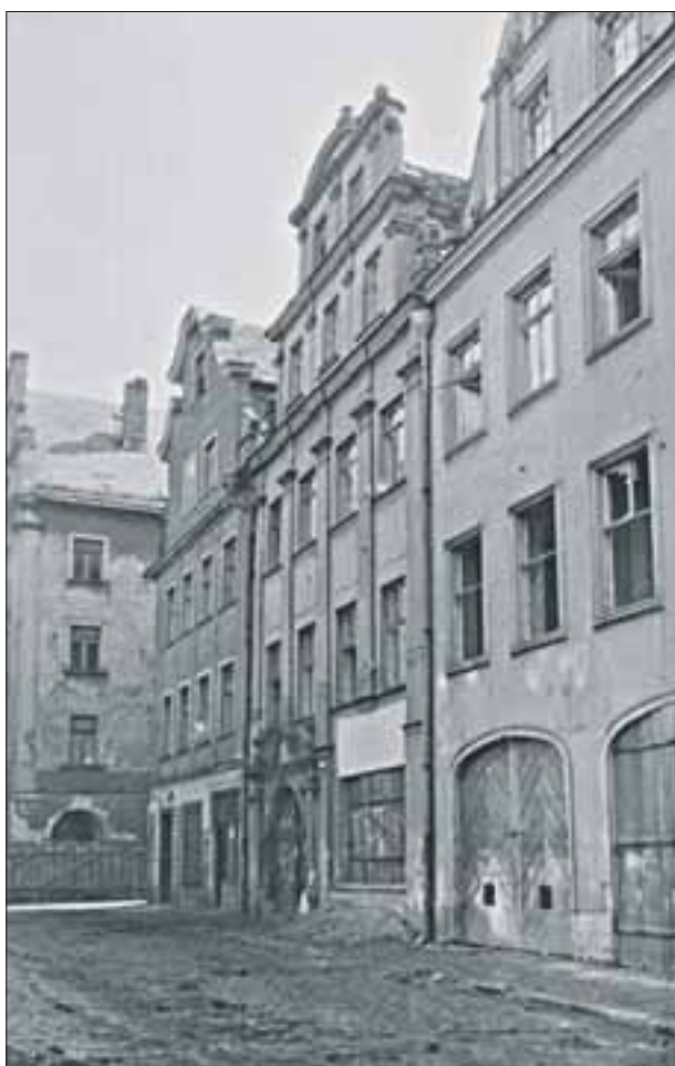
5. Dom mieszkalny w Jeleniej Górze, ul. Grodzka 23, niezniszczony podczas wojny, zamieszkały przez indywidualnych lokatorów, wpisany do rejestru zabytków w 1963 r. pod numerem 1006, zakwalifikowany do I grupy zabytków, skreślony z rejestru w 1966 r. i wyburzony. Fot. ze zbiorów KOBiDZ.
