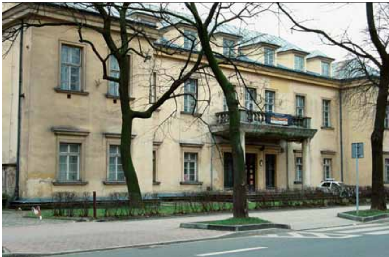
3. Kraków, Pałac przy Szlaku. Fot. E. Szumakowicz.
