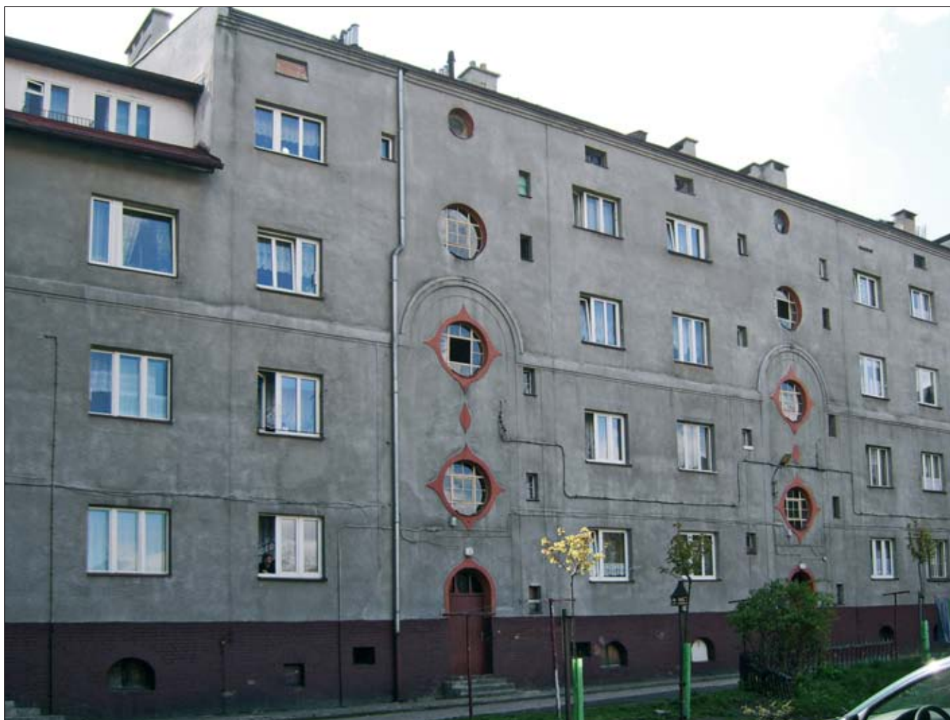
4. Widok na elewację od strony podwórza, ul. Skalna 3-5. 4. View of the elevation from the courtyard, 3-5 Skalna Street.
