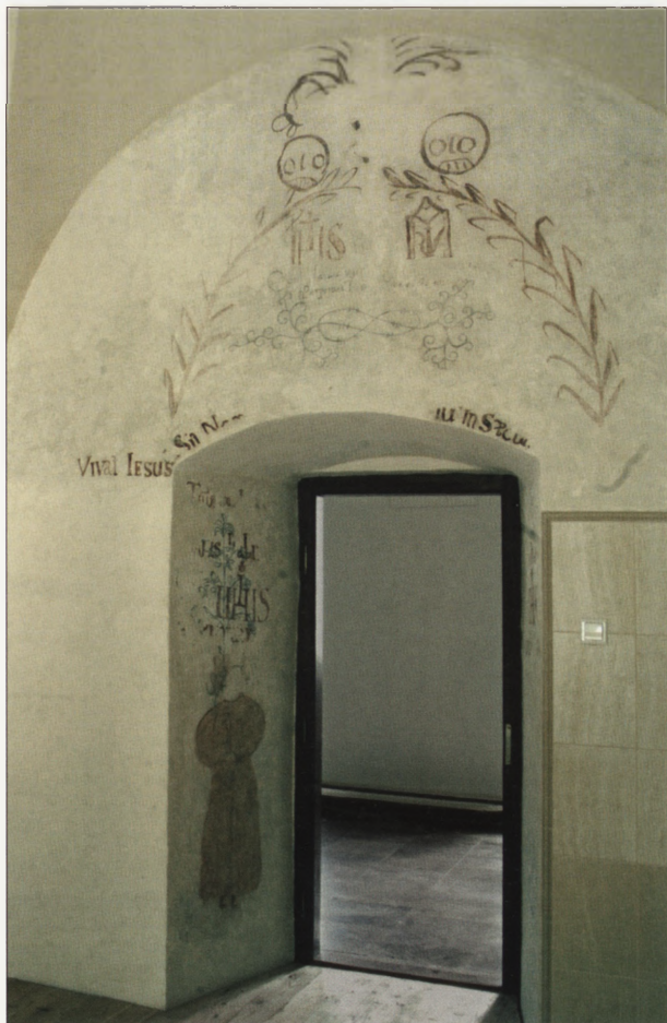
27. Cella nr 6, malowidła ściany wschodniej. 27. Cell no. 6, murals on the east wall.
