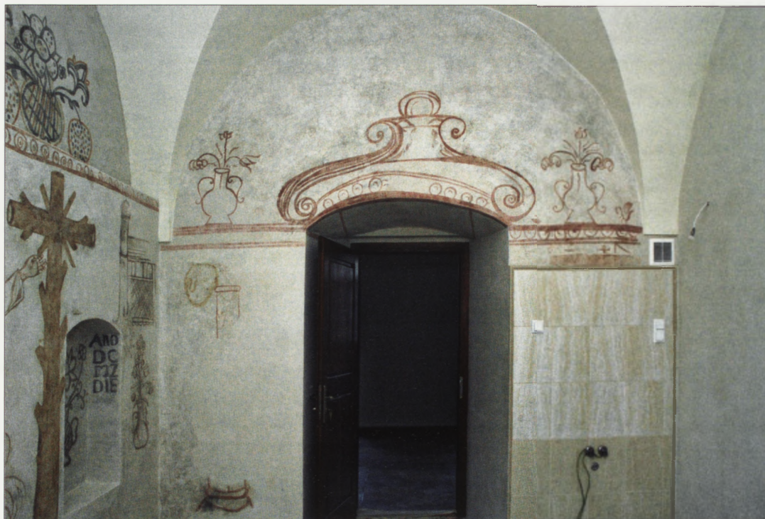
17. Cella nr 4, malowidła ściany wschodniej. 17. Cell no. 4, murals on the east wall.
