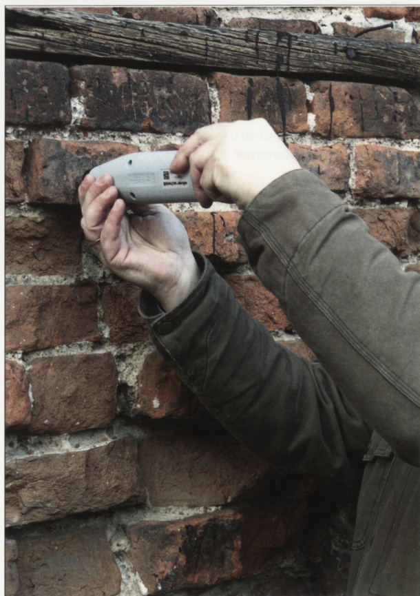
5. Pomiar ceglanoego muru młotkiem Schmidta. Fot. W. Witkowski.
