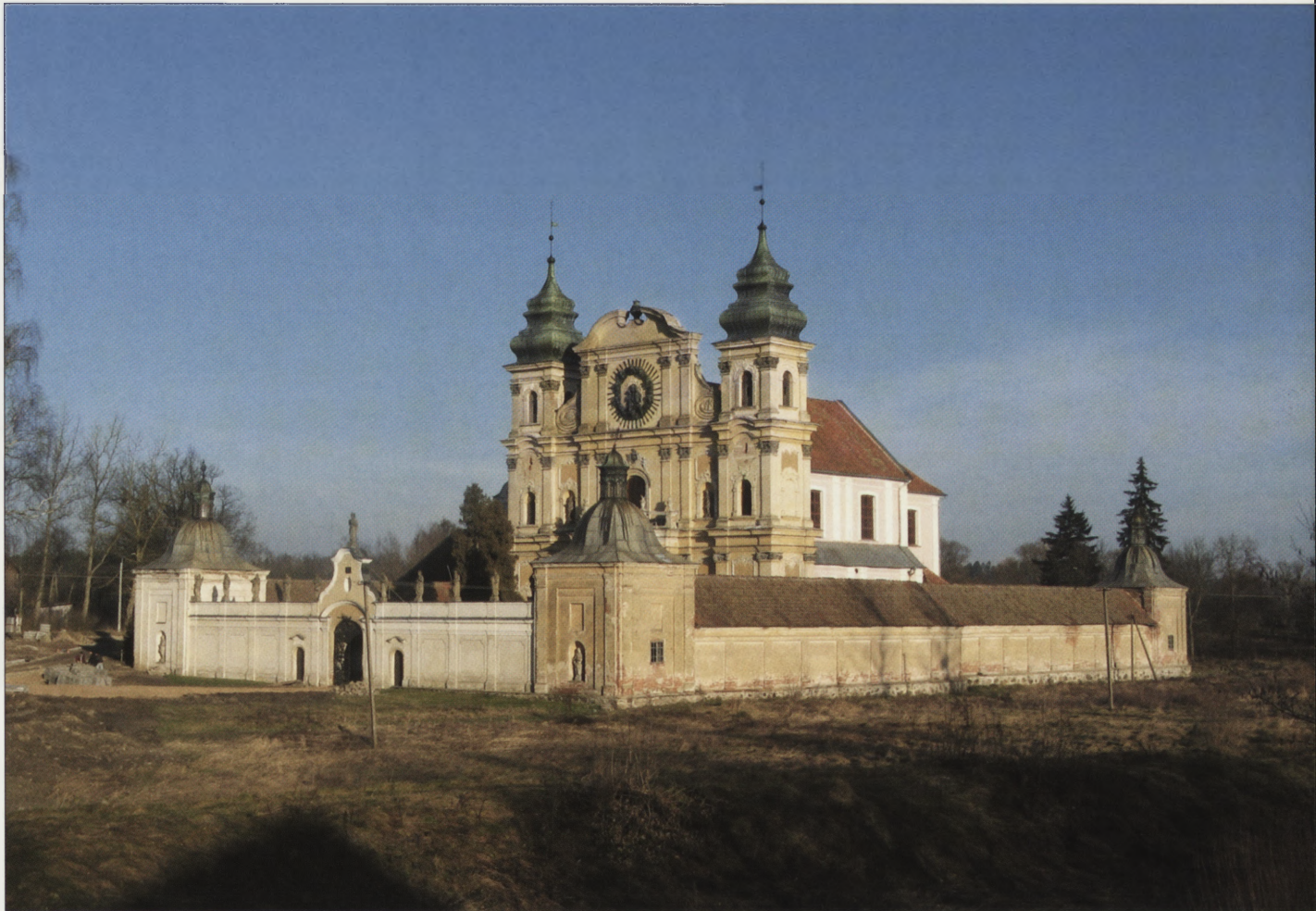
1. Krośno, widok na zespół odpustowy od zachodu. Fot. A. Markowska.
