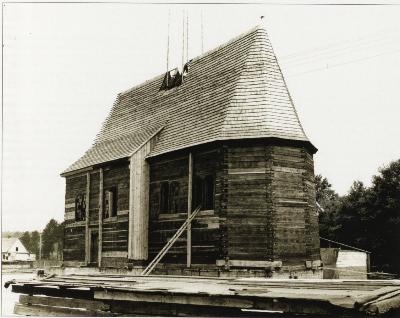
17. Gmolas, drewniany kościół w trakcie demontażu. Fot. M. Kornecki, 1979 r. 17. Gmolas, wooden church during disassembly. Photo by M. Kornecki, 1979.
