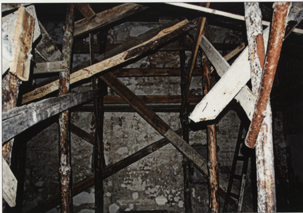
9. Nawa, ściana północna w rusztowaniach. 9. Aisle, northern wall in scaffolds.
