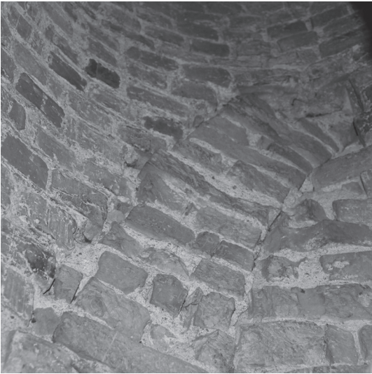
6a. Relikt łuku konstrukcyjnego w zachodniej części wieżycy schodowej
