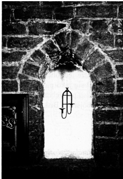
Zdj. 2. Blenda okienna w kamienicy przy ul. Wieżowej 2. Fot. M. Szajerka.
