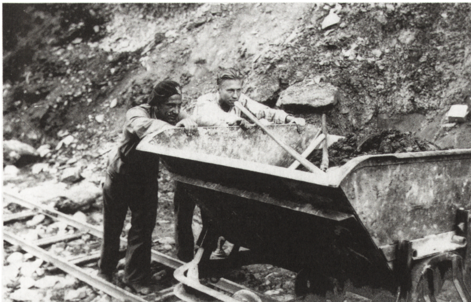
Fot. 4. Studenci polscy podczas budowy drogi w Alpach Szwajcarskich
