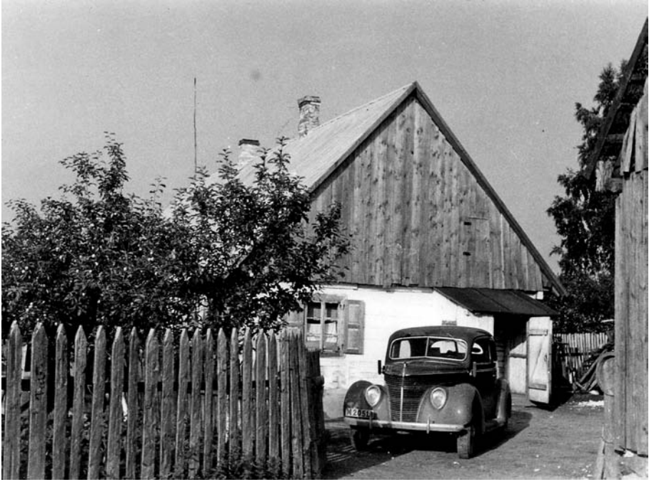
Ryc. 15 Budynek szkoły podstawowej we wsi Jasionowo koło Suwałk
