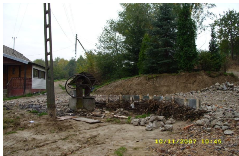
Ryc. 6. Obszar osuwiskowy we wsi Malawa, gm. Krasne. Szkody związane z osuwiskiem spowodowały konieczność stabilizacji i utwardzenia gruzem drogi dojazdowej (fot. P. Krzyk)
