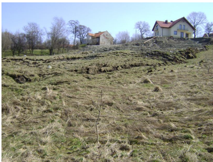
Ryc. 14. Osuwisko w Sierczy, gm. Wieliczka, z widocznym zerwaniem sieci drenarskiej (fot. P. Krzyk)
