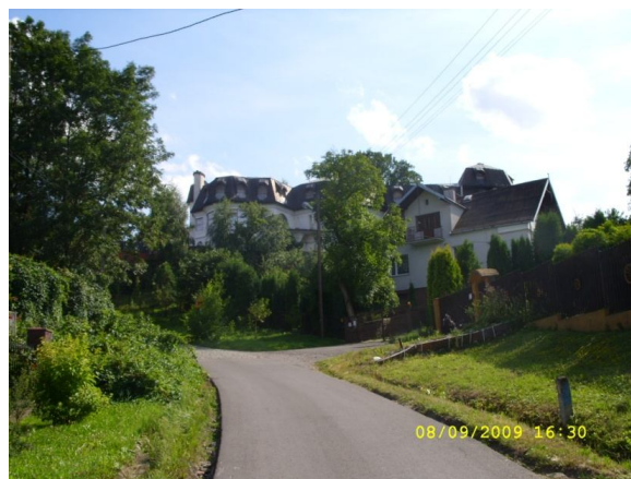
Ryc. 18. Zabudowania sąsiadujące z osuwiskiem na Stoku pod Baranem w Wieliczce; wyżej położony duży, nowy budynek mieszkalny w wyniku ruchów osuwiskowych poważnie uszkodzony i niedopuszczony do użytkowania przez nadzór budowlany (fot. P. Krzyk)
