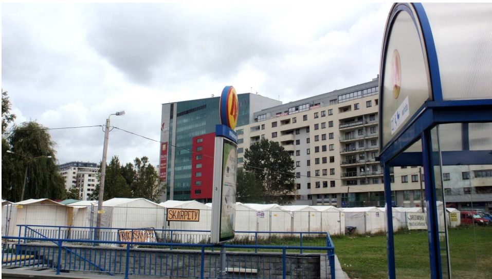
Ryc. 2. Otoczenie stacji metra Wilanowska (fot. M. Staniszkis)
