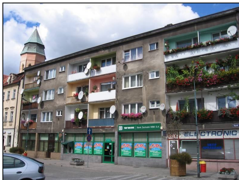
Ryc. 6. Budynek z lat 70. XX w. na ul. Rynek
