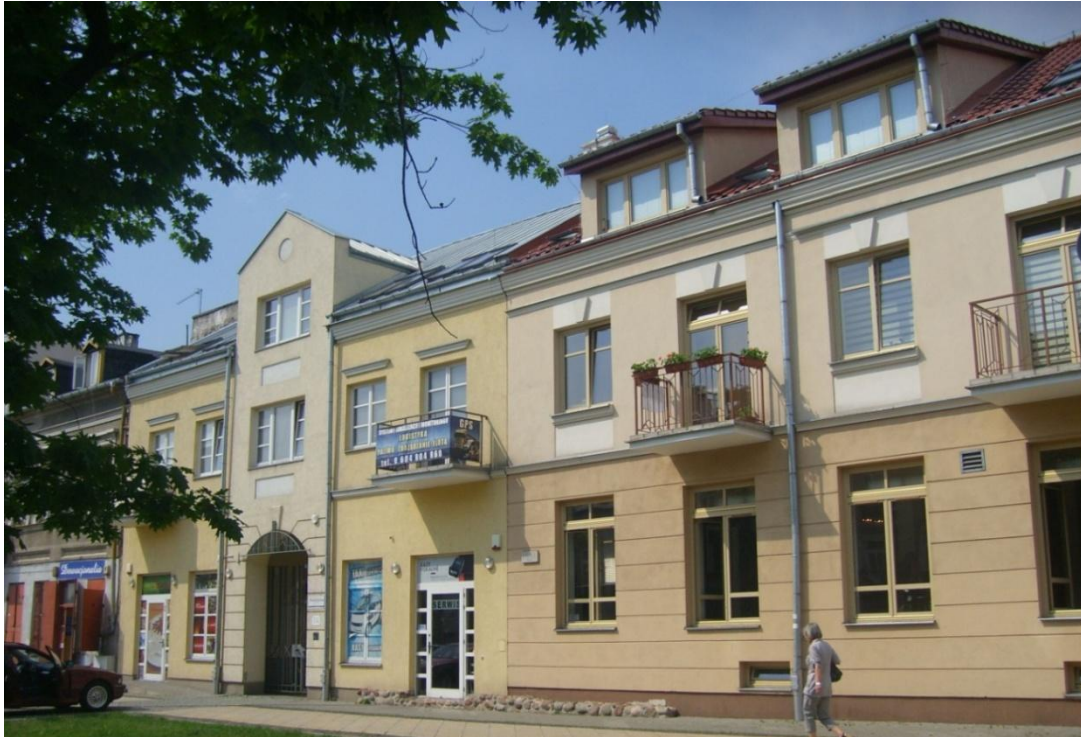
Fot. 2. Nowa zabudowa mieszkaniowa powstająca w obrębie historycznego zespołu architektoniczno-urbanistycznego
