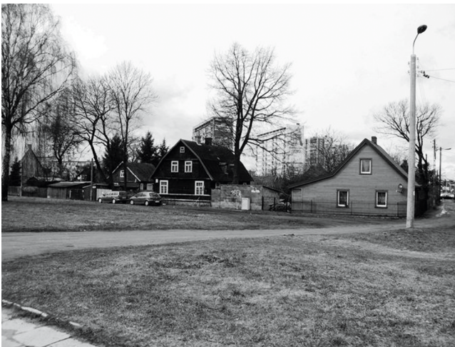
Fot. 2. Przykłady istniejącej zabudowy na analizowanym obszarze
