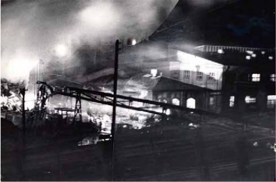
Budynek dekstryniarni w czasie pożaru (AIPN Po, 04/3280, t. 2)
