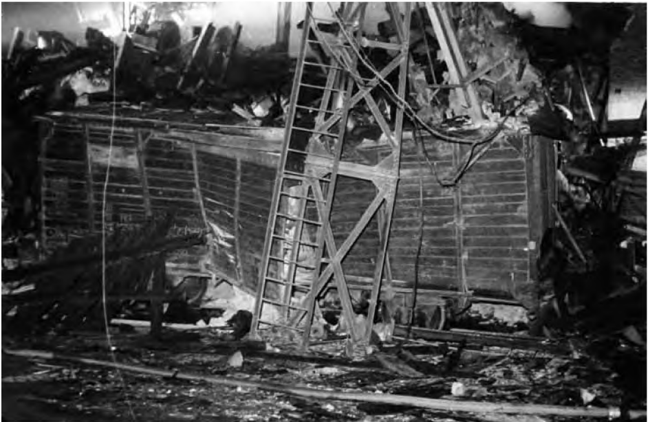
Zniszczony budynek dekstryniarni (AIPN Po, 04/3280, t. 2)
